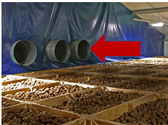
Figure 5&6 Equipements de refroidissement de l'air et conduites associées dans des entrepôts de stockage en caisses
